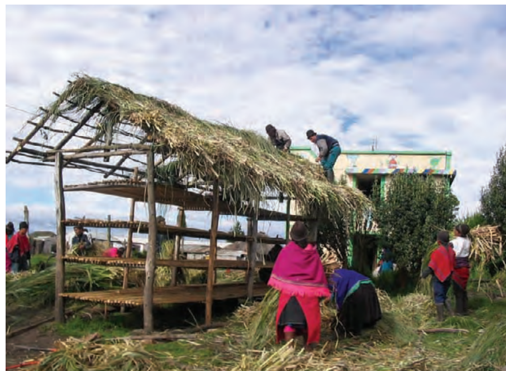
Construcción de un silo verdeador utilizando materiales de la
